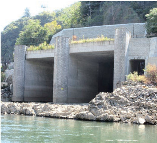
完成したトンネル式放流設備
