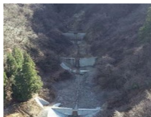
小規模な治山ダムを階段状に配置
