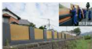
自主防災活動による土留設置 (揖保川水系、たつの市)
