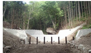
流木捕捉工の設置
