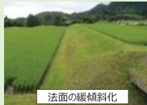
法面の緩傾斜化
