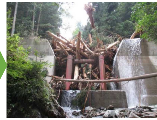
流木捕捉式治山ダムの整備による流木等の捕捉
