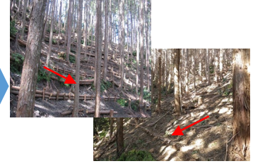
筋工の設置による土壌の保持
