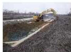
河道掘削 (石狩川水系、北海道開発局)
