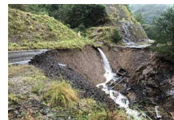
災害に備えた林道の改良整備
