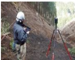
ICT施工の活用
