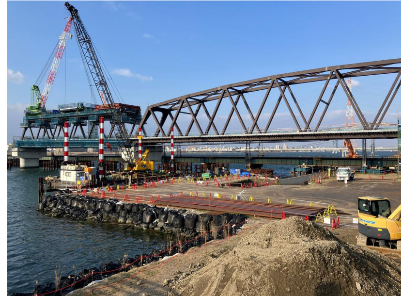
②上部工架設工
