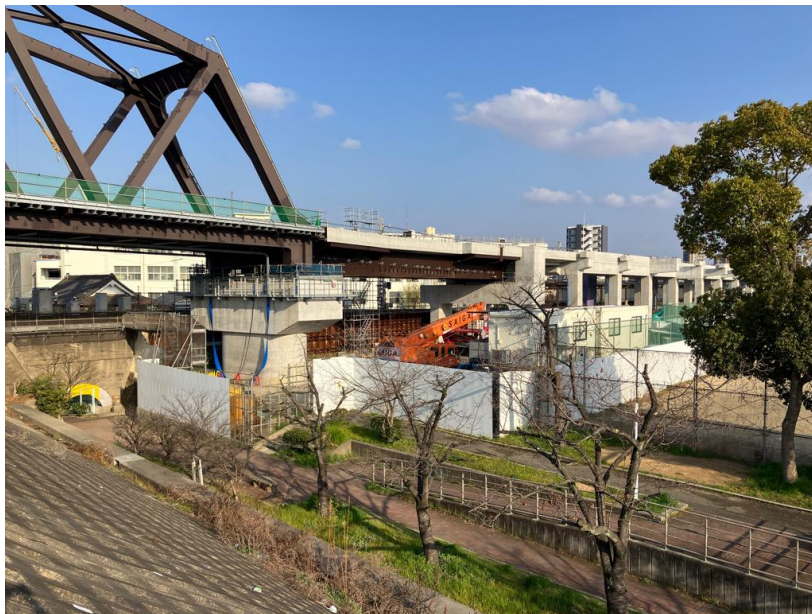
③上部工架設工
