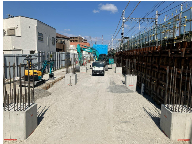
②躯体構築工（埋戻し）
