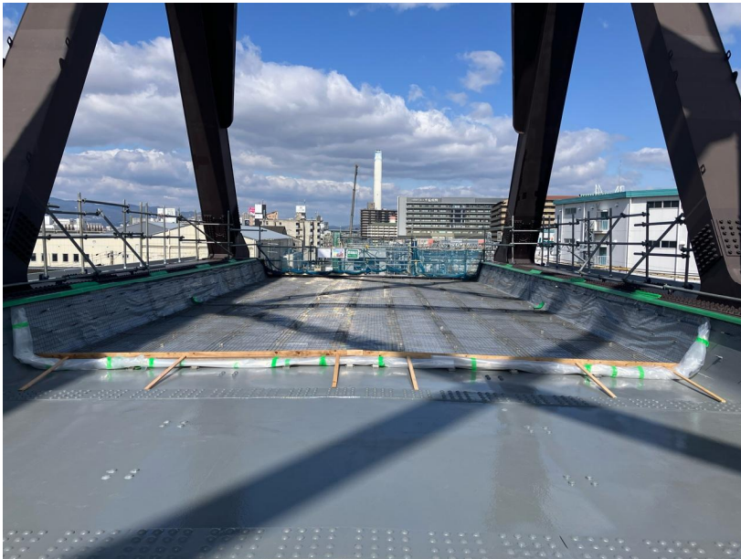
③保護コンクリート打設工
