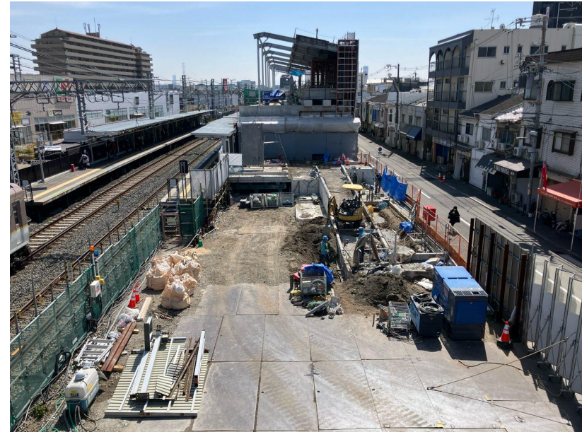
④躯体構築工 (地中梁、柱)
