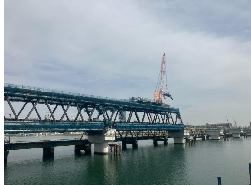
②上部工架設工
