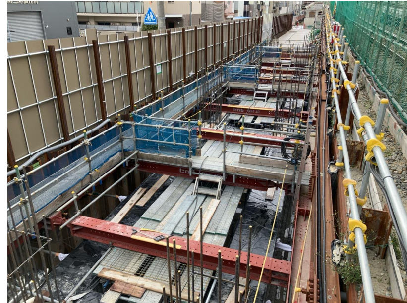
②躯体構築工（地中梁）
