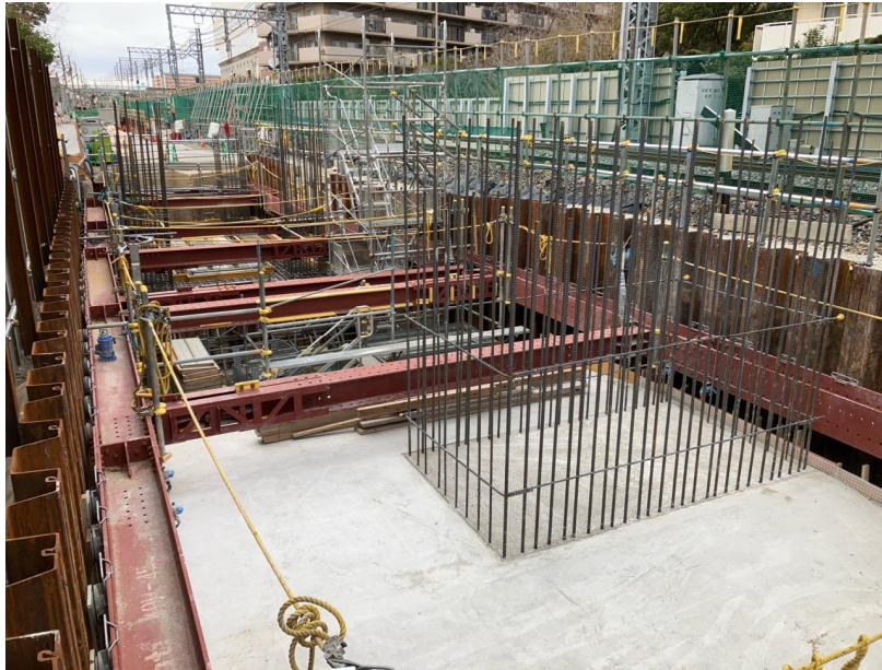
①躯体構築工（フーチング）
