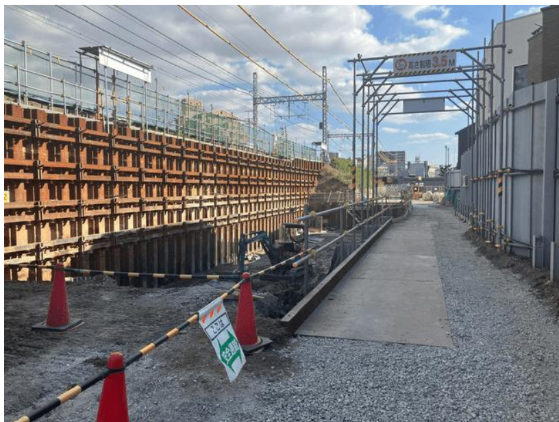
③躯体構築工（掘削）
