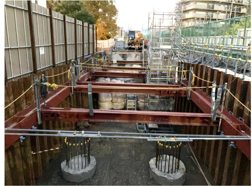
②躯体構築工（掘削、土留支保工）
