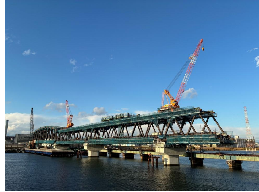
②上部工架設工
