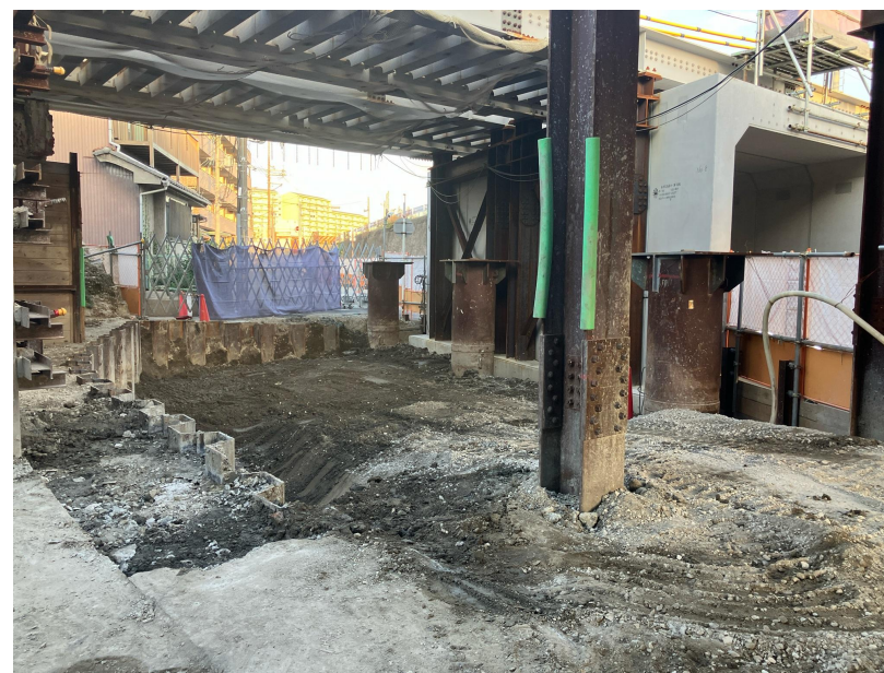
④鋼矢板打設工
