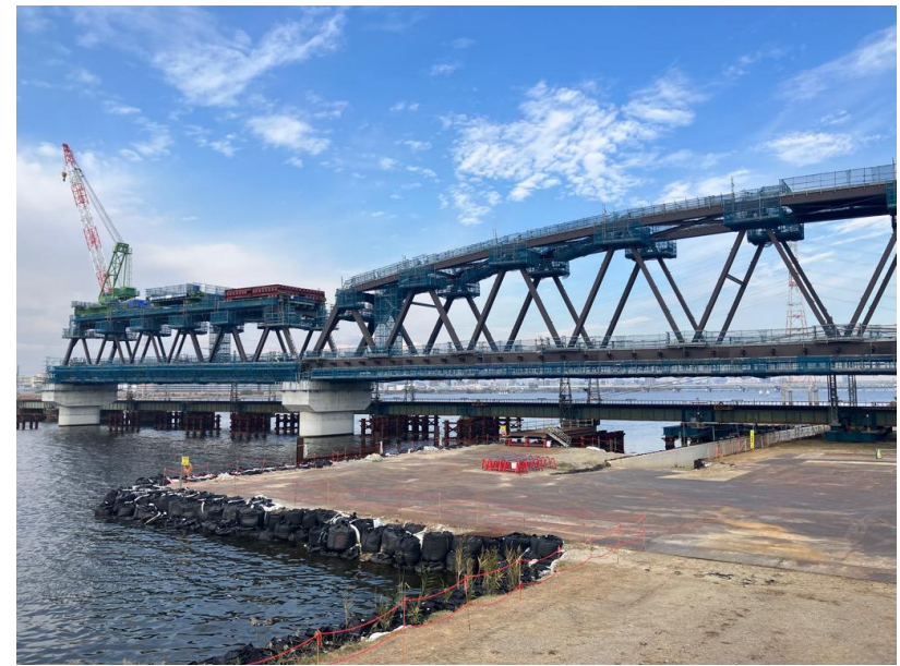
②上部工架設工
