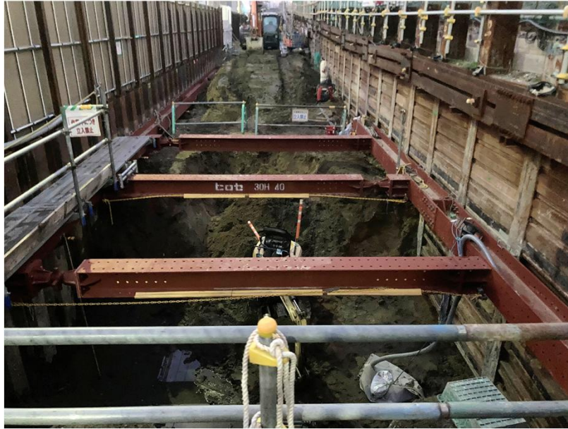
①躯体構築工（掘削、土留支保工）
