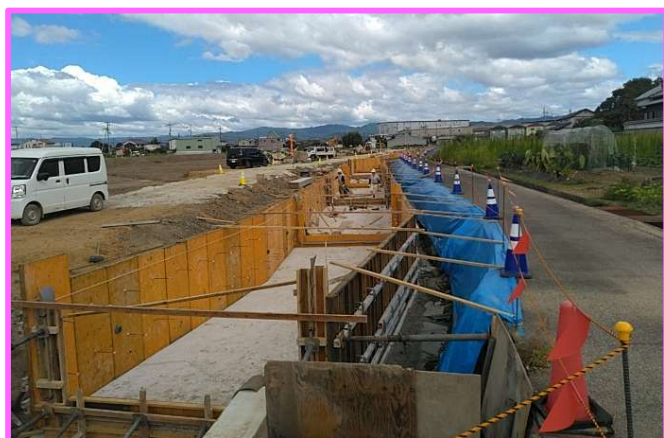
型枠建込状況
