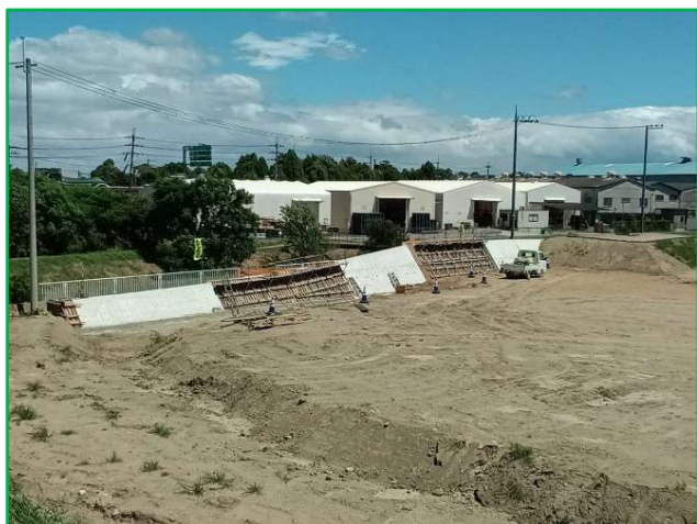
コンクリート打設完了
