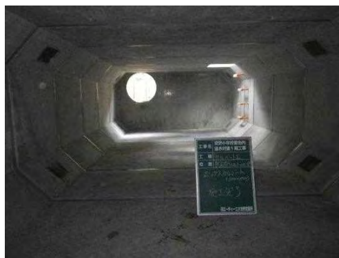
雨水貯留槽の内部
