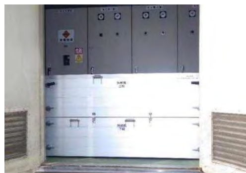
電気室内に設置した止水板
