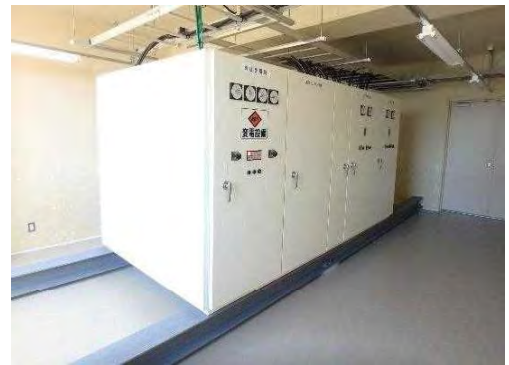
移設後の受変電設備
