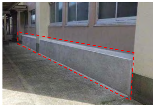
構造体の補強による対策後
