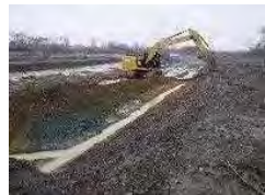
河道掘削 (石狩川水系、北海道開発局)
