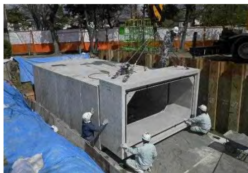
校庭の地下への雨水貯留槽の設置
