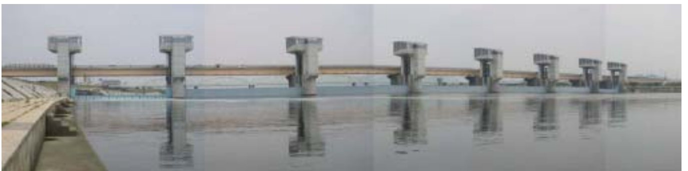
写真 3.21 7号ゲート上段扉放流状況
