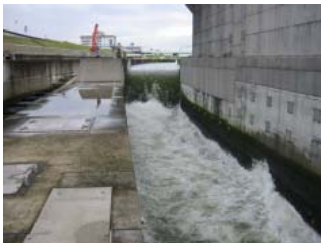
写真 3.24 呼び水ゲート放流状況
