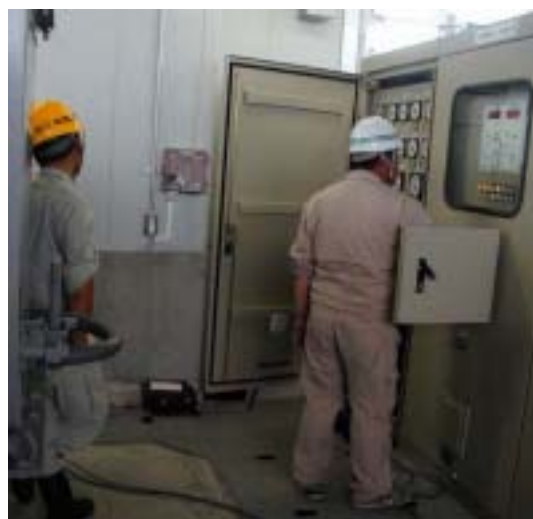
写真 3.31 動作確認状況
