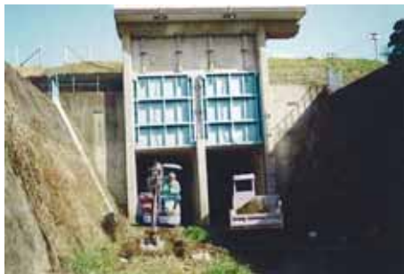
樋門周辺の土砂撤去
