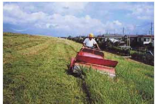
写真 2.4.1 堤防の除草状況
