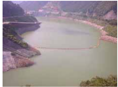
写真 4.4.8 網場設置の様子（大滝ダム）
