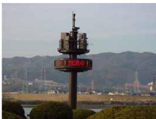
写真 4.4.6 紀の川大堰警報局及び電光表示板
