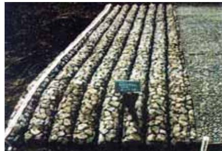
木や石などの自然素材を用いた伝統工法等を採用することによる良好な水辺景観に配慮した護岸補修
