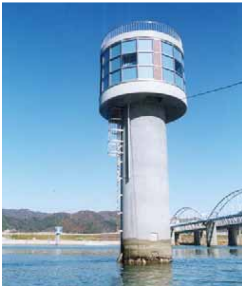
写真 2.4.6 紀の川大堰-水質監視
