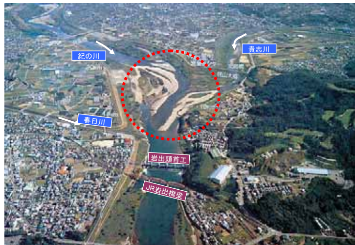
写真 2.1.1 岩出頭首工上流の土砂堆積状況
