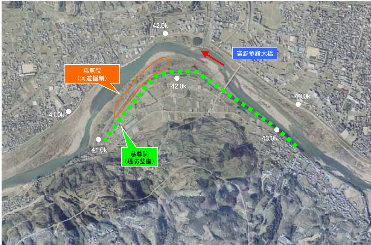
写真 4.1.4 河道の整備（和歌山県九度山町）
