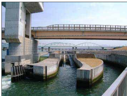
写真 2.3.6 紀の川大堰魚道（左岸 6.2k）
