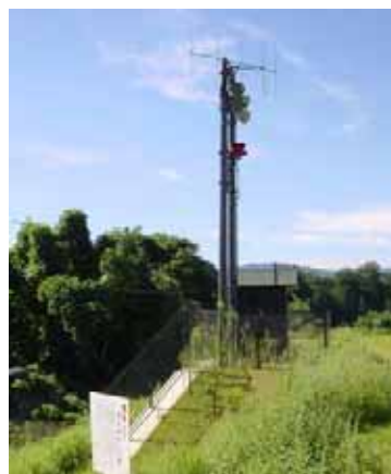
写真 4.4.7 大滝ダム警報局
