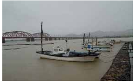
写真 2.3.14 不法係留の状況（左岸 3.6k 付近）
