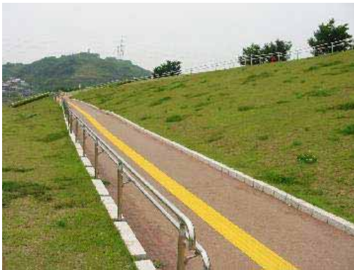
写真 4.3.2 緩勾配の坂路
