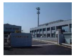
▲大滝ダム管理支所(f)
