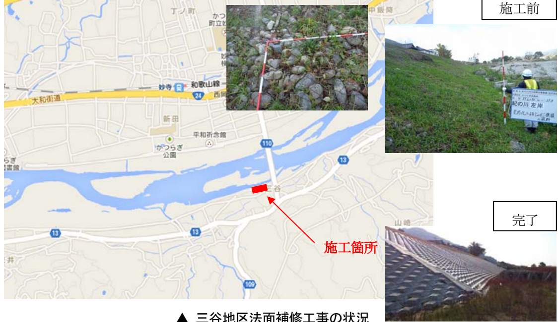
▲ 三谷地区法面補修工事の状況
