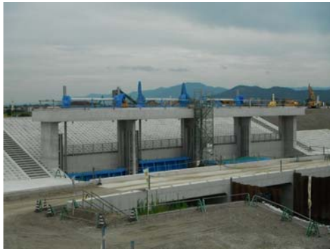
本体工が完了した鴨井樋門
