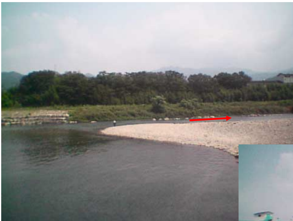
↑ ①小田井堰下流付近
