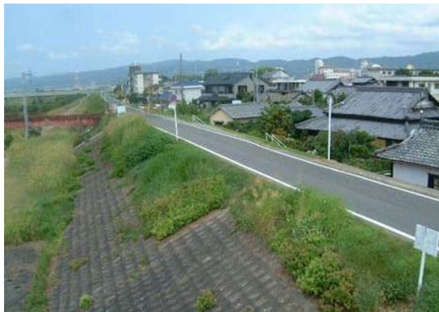
↑ ③JR和歌山線岩出橋梁付近(右岸堤防)
