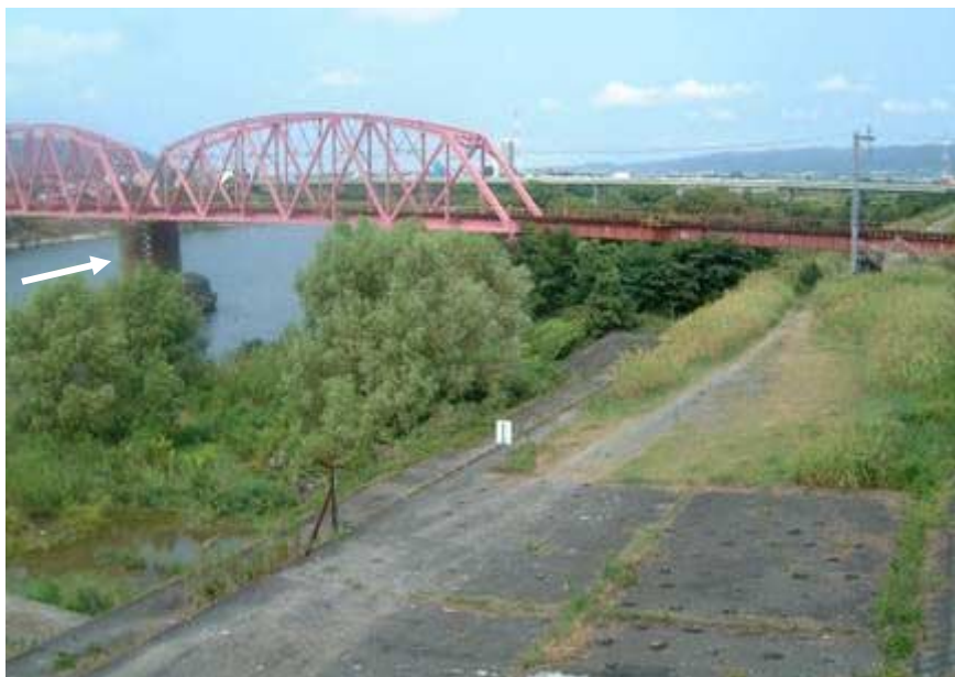
↑ ②JR和歌山線岩出橋梁付近(右岸)
