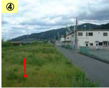
④ 築堤工事が未実施
