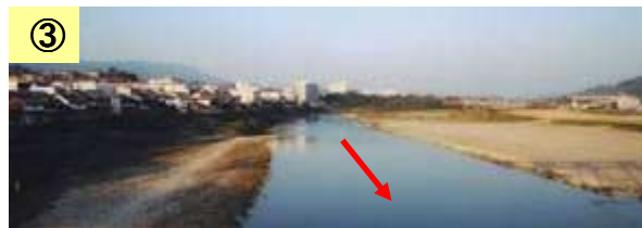
土砂が堆積している。→
