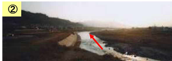
←土砂が堆積している。
