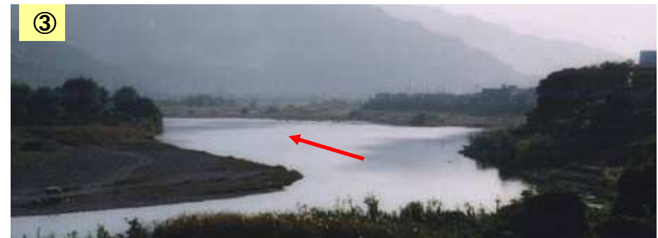
河床に砂が堆積している
