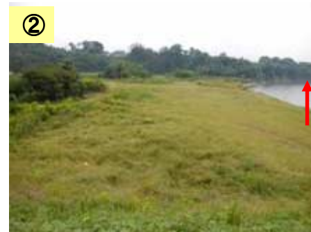
築堤工事が未実施
