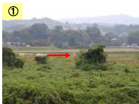
築堤工事が未実施
