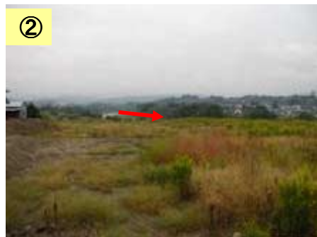
② 築堤工事が未実施
