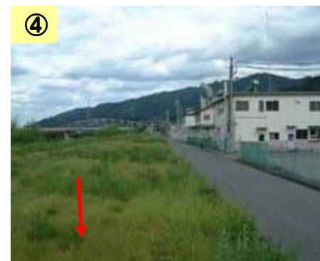
④ 築堤工事が未実施
