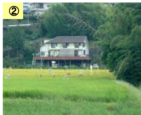
② ピロティ構造の住宅
