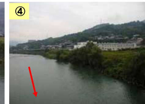
築堤工事が未実施
