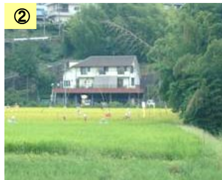
② ピロティ構造の住宅
