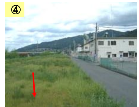
④ 築堤工事が未実施
