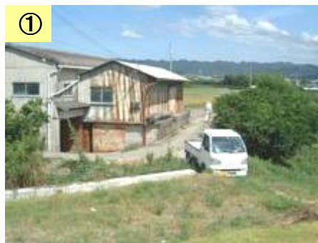
① 堤内地に人家が点在する
