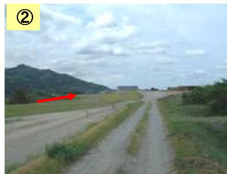
② 築堤工事中である
