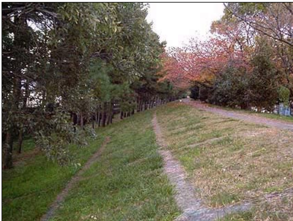
畠山氏による波除石垣、浜口梧陵による防波堤と防潮林の三段構えで築き上げられた今も広川に残る堤防
