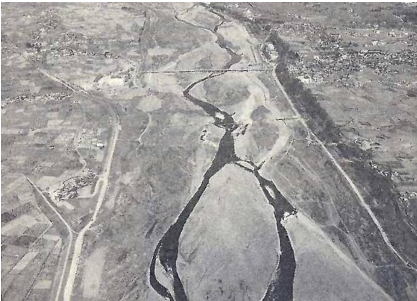
信玄堤付近全景（出典：ふるさと土木史）
