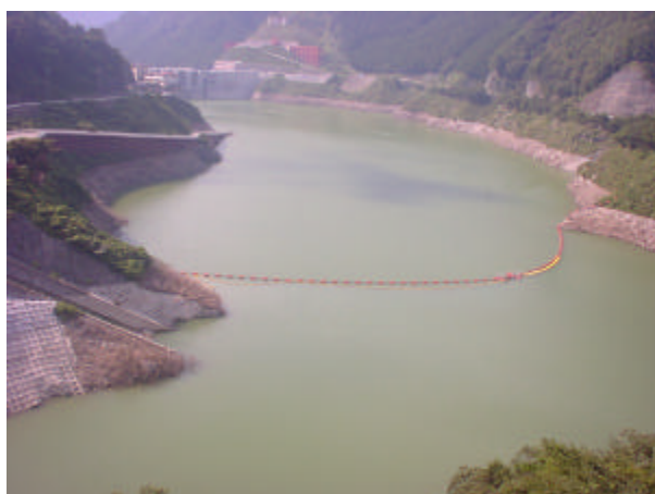
図4.4.6 網場設置の様子 (大滝ダム)
