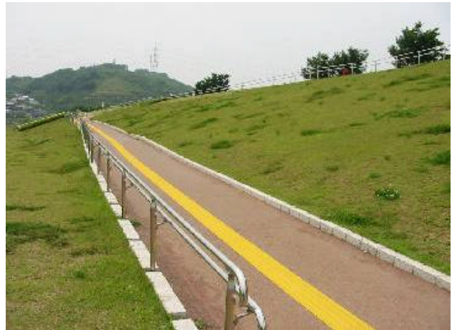
図4.4.8 アクセス改善の様子（緩勾配の坂路）
