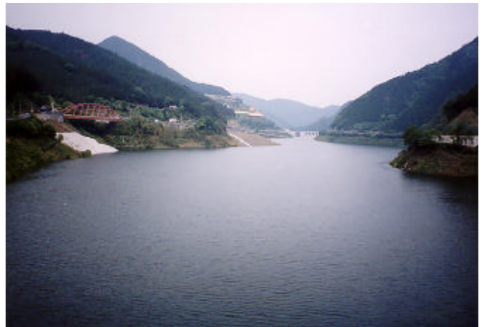
図2.3.12 北塩谷橋下流（大滝ダム）
