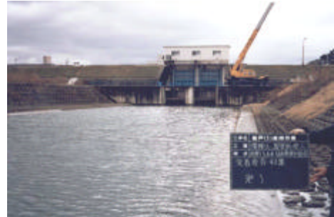
図2.4.10 有本揚排水機場(取水口付近)
