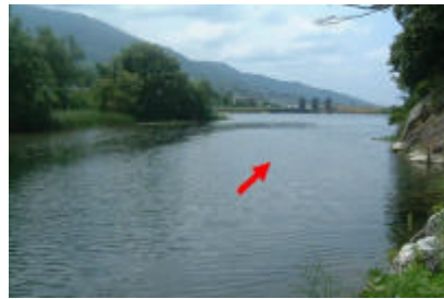
図2.3.2 堰 (藤崎井堰) の湛水区間
