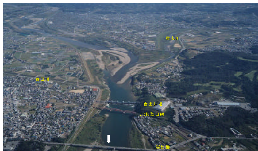
図2.1.4 岩出井堰付近
