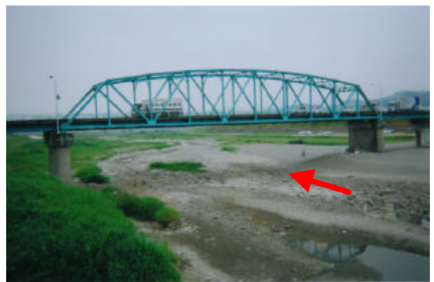
図2.2.5 貴志川の瀬切れの様子 (諸井井堰下流 (平成14年6月))
