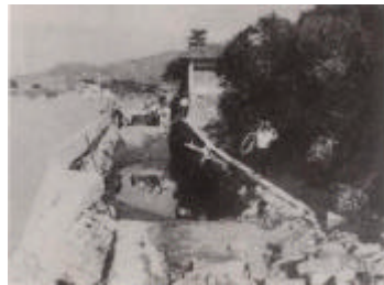
図1.8 昭和28年台風13号による被害状況 (県道海南九度山線 麻生津～電門間)
