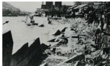
図1.9 昭和34年台風9号による被害状況 (告野町上市付近)
