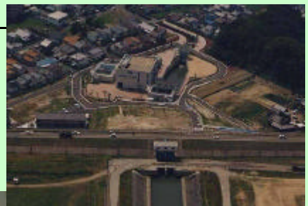
有本揚排水機場
