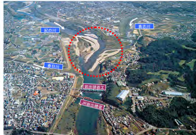
写真 2.1.1 岩出頭首工上流の土砂堆積状況
