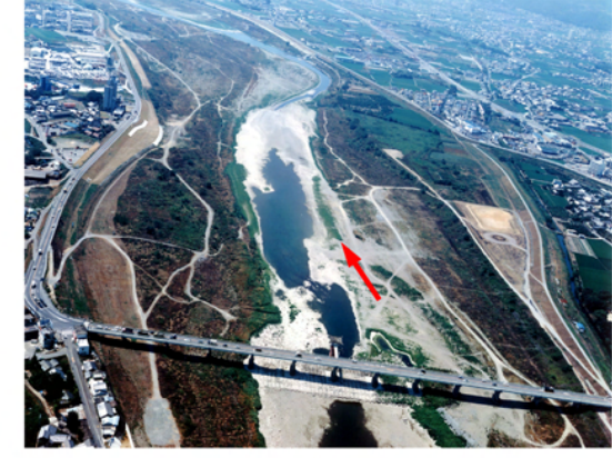
写真 2.2.1 岩出橋付近の瀬切れ (平成6年8月)
