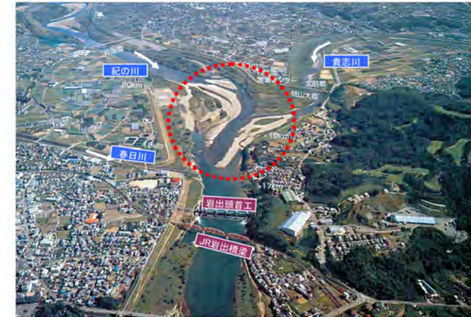
写真 2.1.1 岩出頭首工上流の土砂堆積状況
