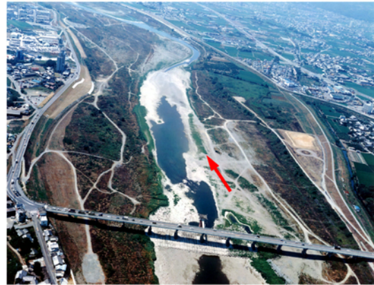
写真 2.2.1 岩出橋付近の瀬切れ (平成6年8月)
