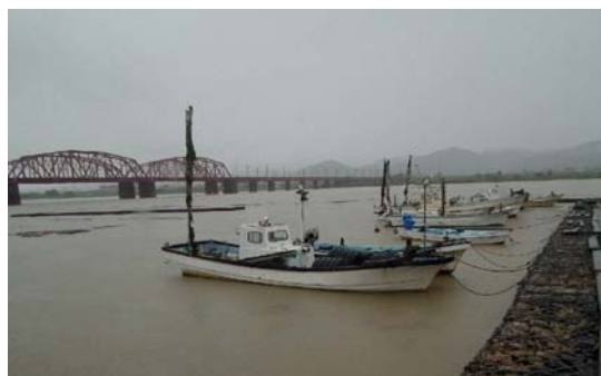
写真 2.3.14 不法係留の状況（左岸 3.6k 付近）
