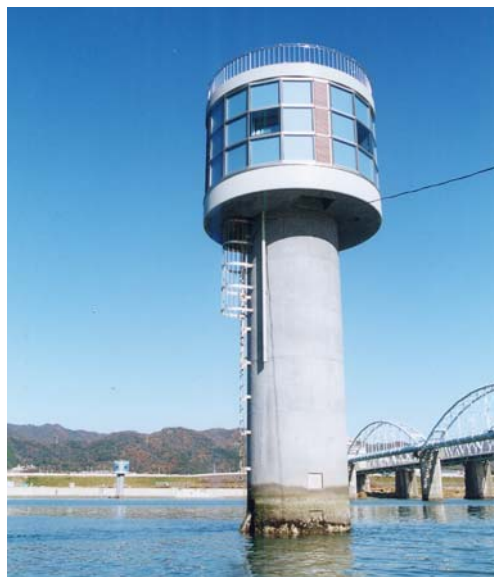
写真 2.4.6 紀の川大堰-水質監視
