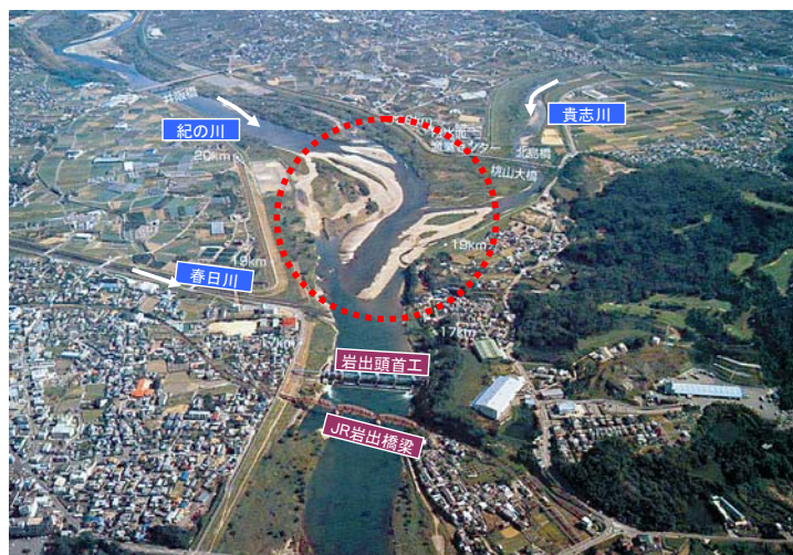
写真 2.1.1 岩出頭首工上流の土砂堆積状況
