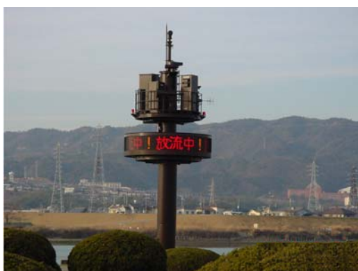
写真 4.4.6 紀の川大堰警報局及び電光表示板
