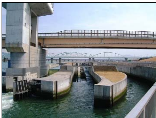
写真 2.3.6 紀の川大堰魚道 (左岸 6.2k)
