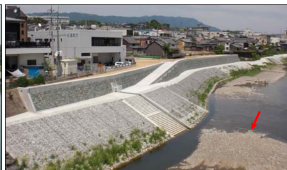
写真 4.3.5 整備後（橋本橋直上流）
