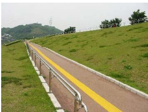
写真 4.3.2 緩勾配の坂路
