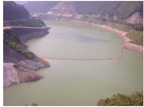
写真 4.4.8 網場設置の様子（大滝ダム）
