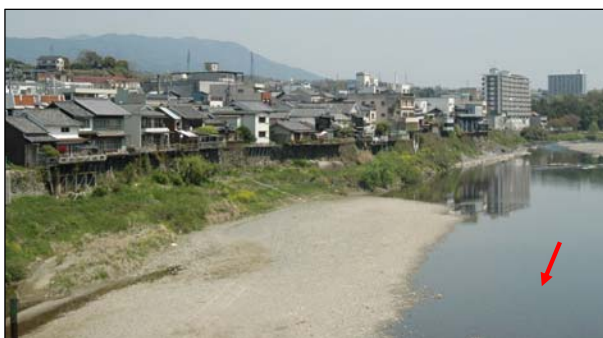
写真 4.3.4 整備前（橋本橋直上流）
