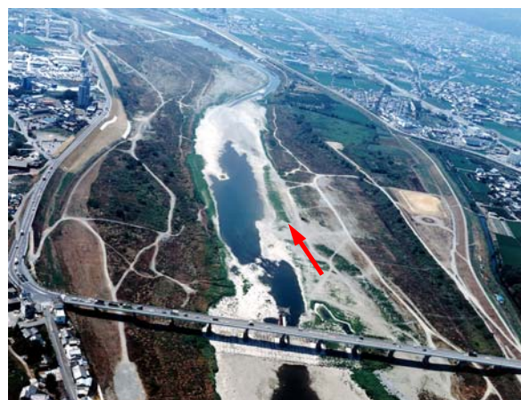
写真 2.2.1 岩出橋付近の瀬切れ (平成6年8月)
