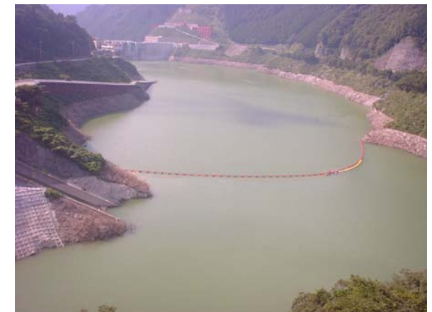
▲網場設置の様子(大滝ダム)
