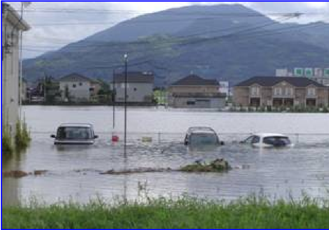
丸栖樋門付近(貴志川左岸0.2k)
