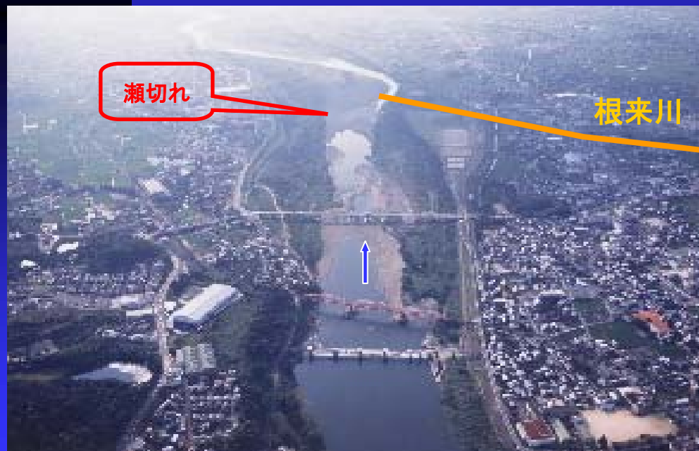
↑ 岩出井堰付近状況(H13.8)
