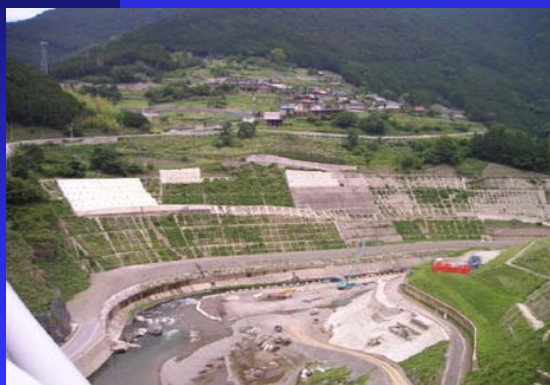
白屋地区全景 (平成18年6月16日撮影)
