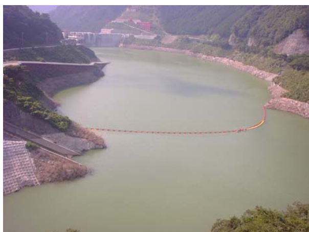
図4.4.6 網場設置の様子(大滝ダム)
