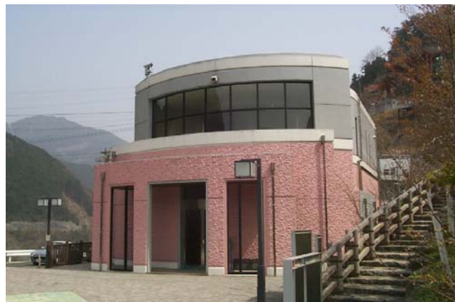
図4.4.5 大滝ダム学べる建設ステーション
