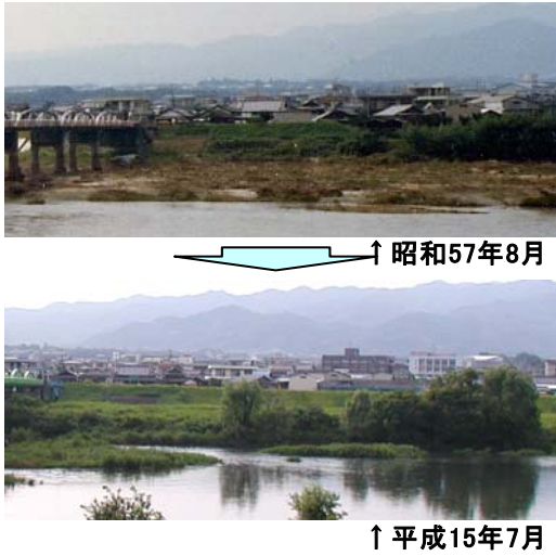
図2.4.8 麻生津橋上流の樹木の変化
