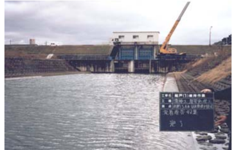
図2.4.10 有本揚排水機場(取水口付近)
