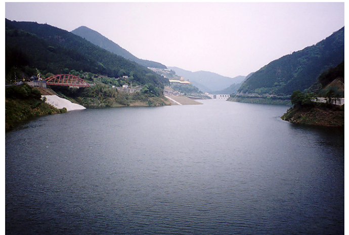
図2.3.12 北塩谷橋下流(大滝ダム)
