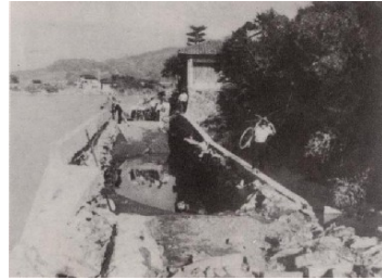
図1.8 昭和28年台風13号による被害状況 (県道海南九度山線:麻生津～竜門間)
