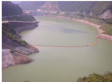
図4.4.6 網場設置の様子(大滝ダム)
