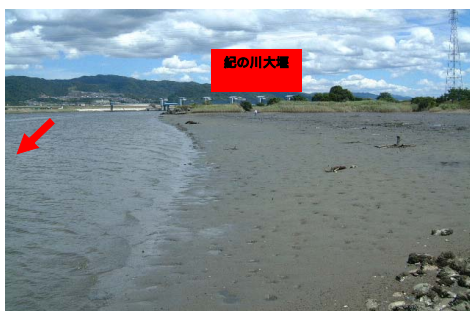
図2.3.7 河口干潟(左岸6k付近)
