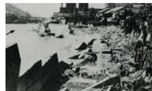
図1.9 昭和34年台風9号による被害状況 (吉野町上市付近)
