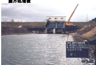
図2.4.10 有本揚排水機場(取水口付近)
