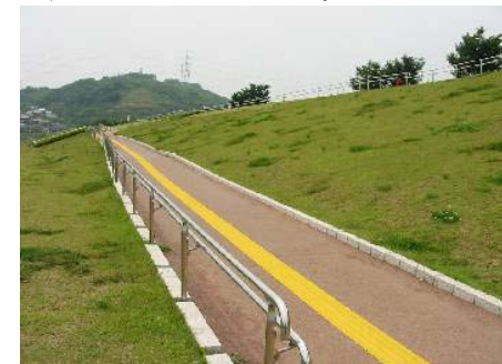
図4.4.8 アクセス改善の様子(緩勾配の坂路)
