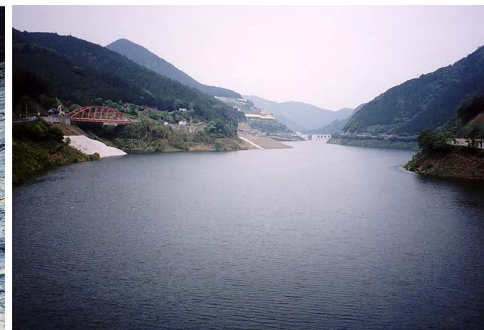
図2.3.12 北塩谷橋下流(大滝ダム)
