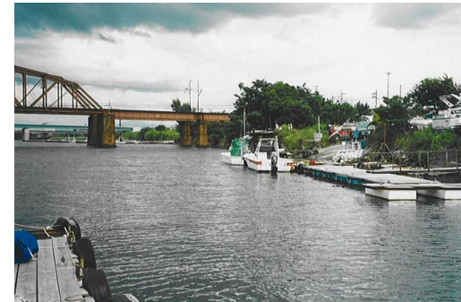
図2.4.18 紀の川での係留の様子(和歌山市東布経町地先:3.5k左岸)
