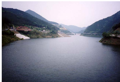
図2.3.13 北塩谷橋下流(大滝ダム)
