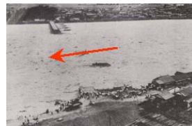
図1.7 昭和28年7月梅雨前線による被害状況 (岩出橋付近)
