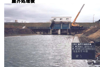
図2.4.10 有本揚排水機場(取水口付近)
