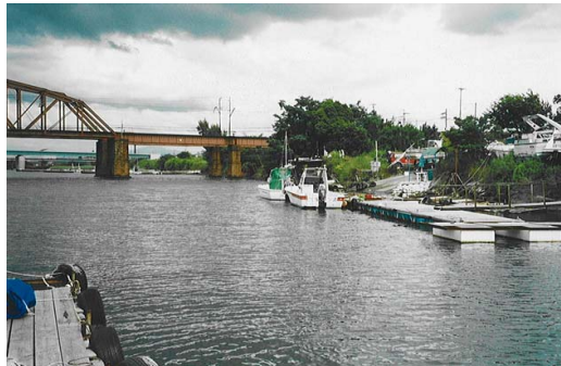
図2.4.18 紀の川での係留の様子(和歌山市東布経町地先:3.5k左岸)
