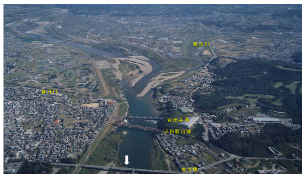
図2.1.4 岩出井堰付近
