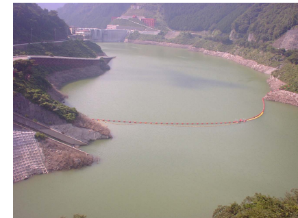
図4.4.6 網場設置の様子(大滝ダム)
