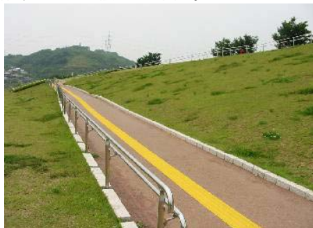
図4.4.8 アクセス改善の様子(緩勾配の坂路)
