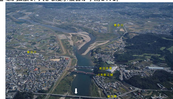
図2.1.4 岩出井堰付近
