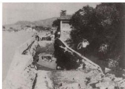
図1.8 昭和28年台風13号による被害状況 (県道海南九度山線・麻生津～竜門間)
