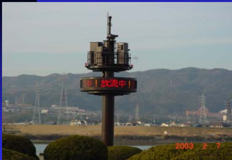
↑ 紀の川大堰警報局及び電光表示板
