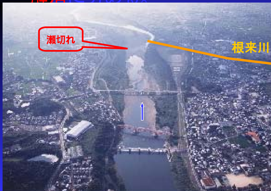
↑ 岩出井堰付近状況(H13.8)
