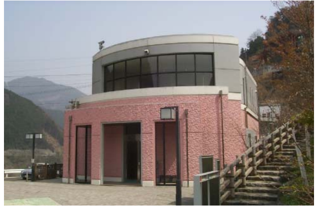
図4.4.5 大滝ダム学べる建設ステーション
