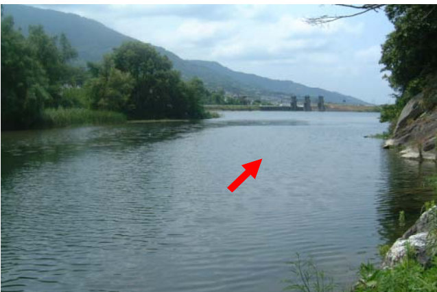
図2.3.10 藤崎井堰と上流の中州(29k付近)
