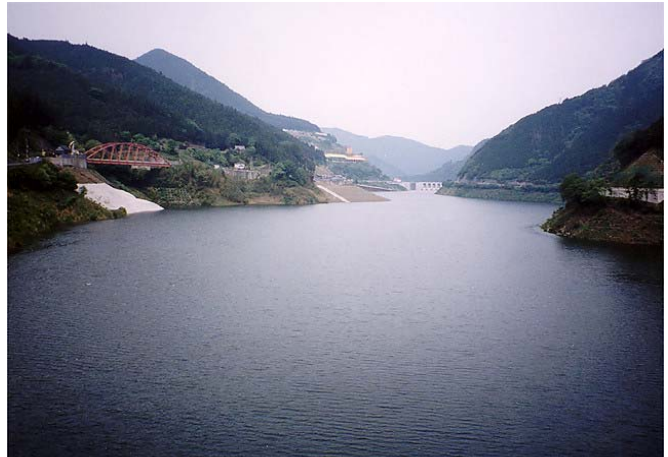
図2.3.13 北塩谷橋下流(大滝ダム)
