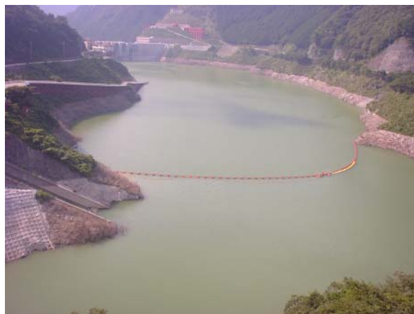
図4.4.6 網場設置の様子(大滝ダム)
