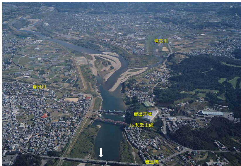
図2.1.4 岩出井堰付近
