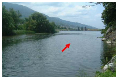
図2.3.2 堰(藤崎井堰)の湛水区間
