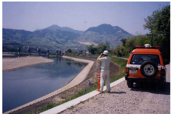
図4.4.10 河川巡視の様子
