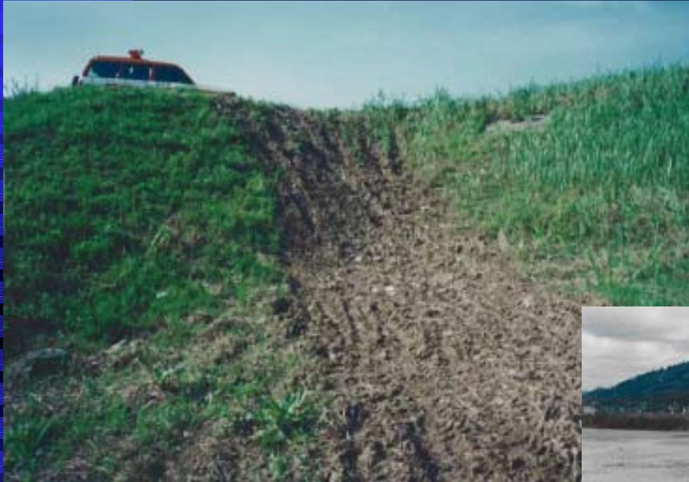
↑ 車両が法面を走行したために生じたわだちによる損傷事例です。
