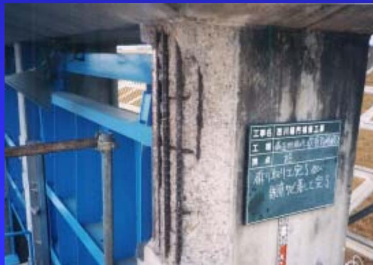
↑ コンクリートを削り、鉄筋の錆びを落とし、防錆剤を塗布して、補修を行いました。西川樋門(平成15年5月)
