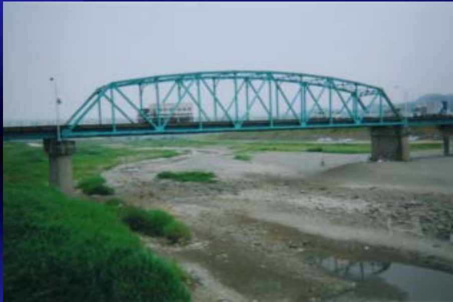
平成14年6月 貴志川(諸井井堰下流)
