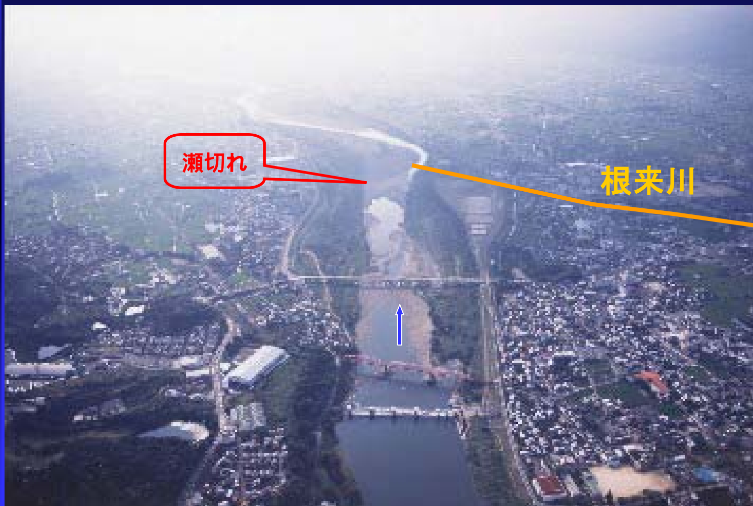
岩出井堰付近状況 (H13. 8)
