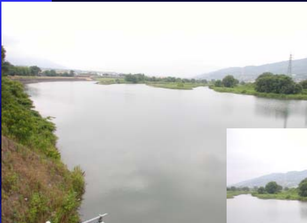
小田井堰上流部付近 (45 k 付近：高野口町・九度山町)
