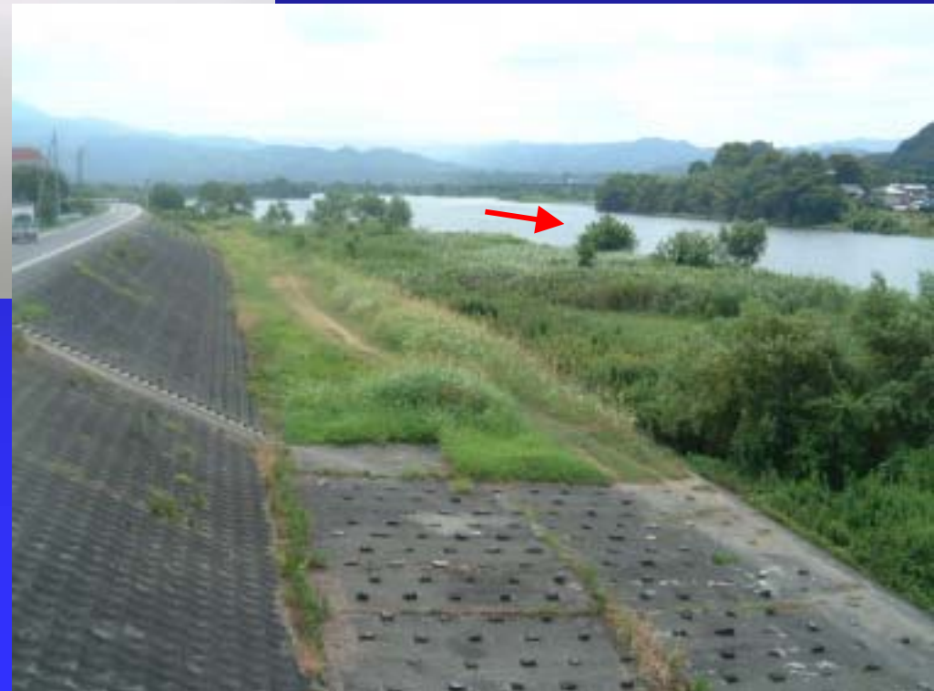
改築に伴う掘削箇所付近 (岩出井堰上流部右岸(17k付近):岩出町)
