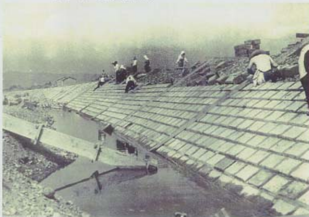
東貴志村右岸ショートカット部の コンクリートブロック積造岸壁工事状況
