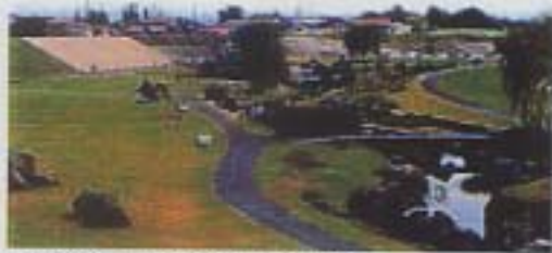
三迫川築堤護岸(左岸)金成町沢辺
