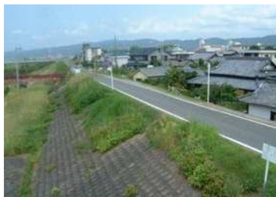
②JR和歌山線岩出橋梁付近(右岸堤防)
