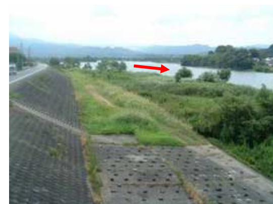
③岩出井堰上流付近(右岸)
