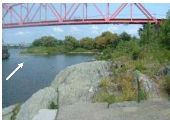
①JR和歌山線岩出橋梁付近(右岸)
