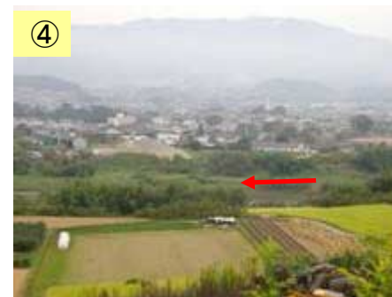
築堤工事が未実施
