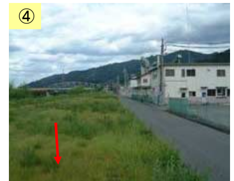
築堤工事が未実施
