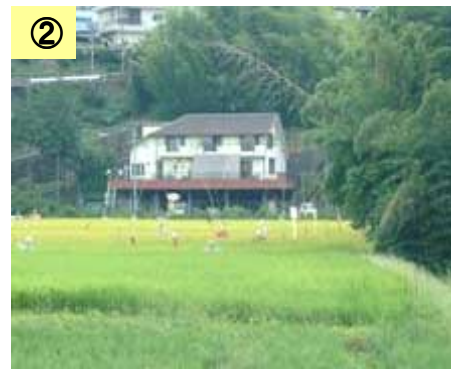
② ピロティ構造の住宅
