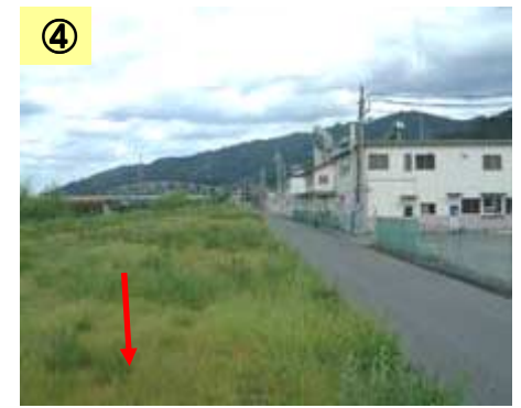
④ 築堤工事が未実施
