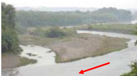
河畔林が繁茂(下流より)
