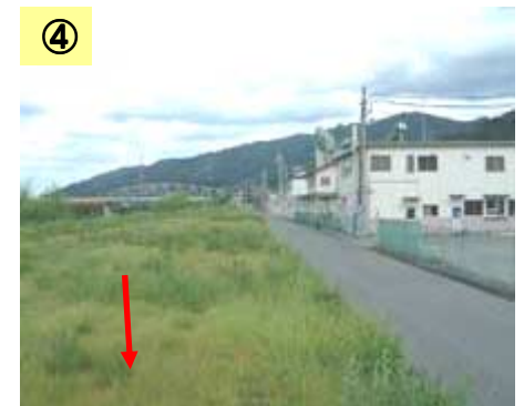
築堤工事が未実施
