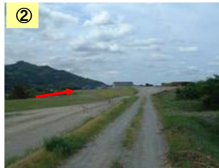
② 築堤工事中である
