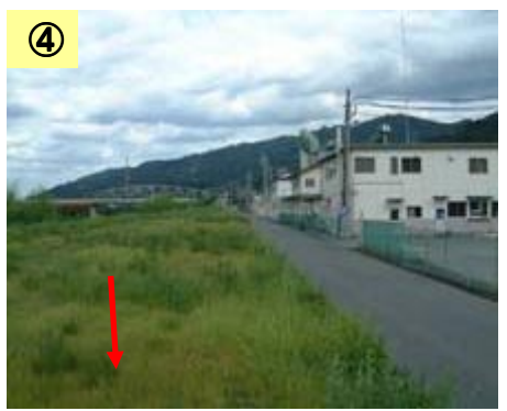
④ 築堤工事が未実施
