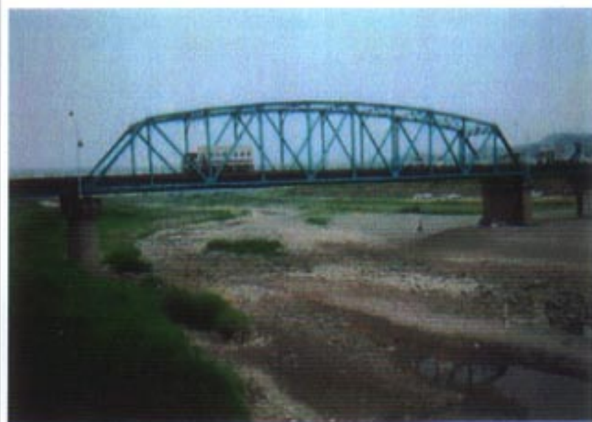
貴志川諸井井堰下流の瀬切れ現象（平成14年6月）
