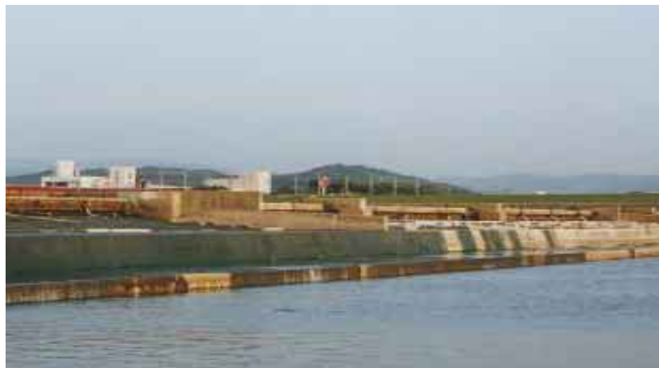
新六ヶ井堰渇水状況
