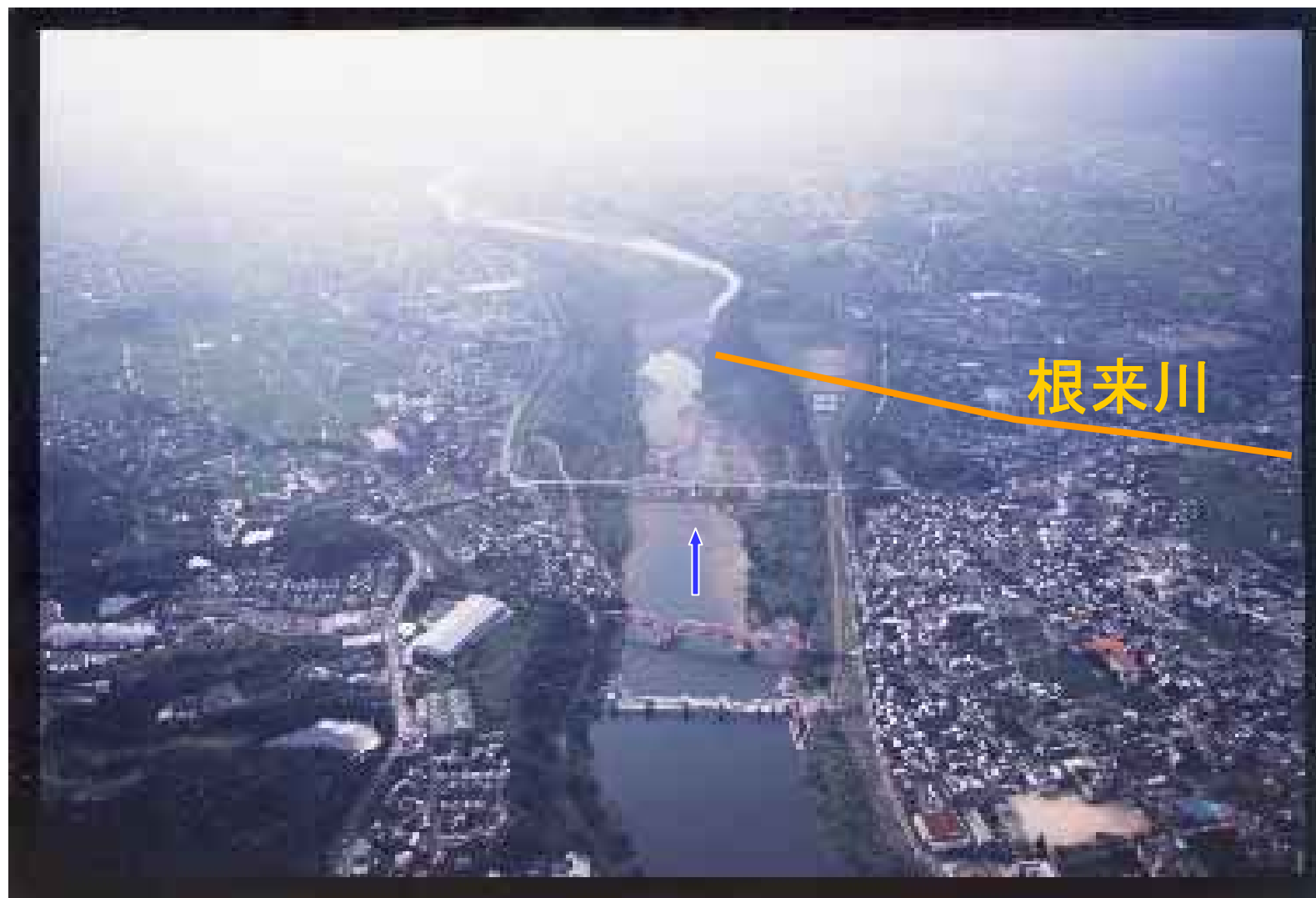
岩出井堰付近状況 (H13. 8)
